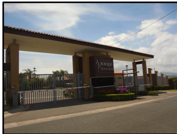
Ilustración 7. Vista de la vía 3 a la entrada en condominio y las vías internas.
