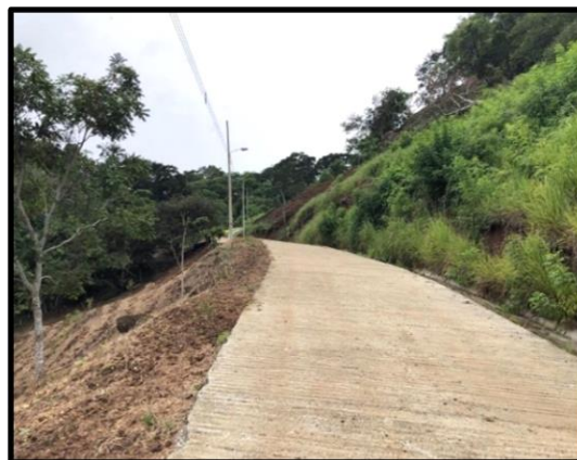
Ilustración 15. Ejemplo de vía 5, por servidumbre de paso agrícola.
