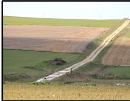
Ilustración 16. Ejemplo de vía 6, por servidumbre de paso agrícola.
